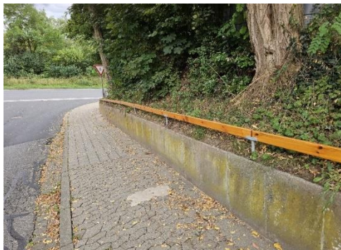
Erneuerung des Geländers/Handlaufs an der Schlesienstraße
