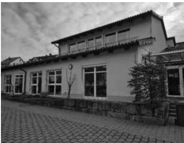
Anbau Krippe an der KiTa Regenbogen
